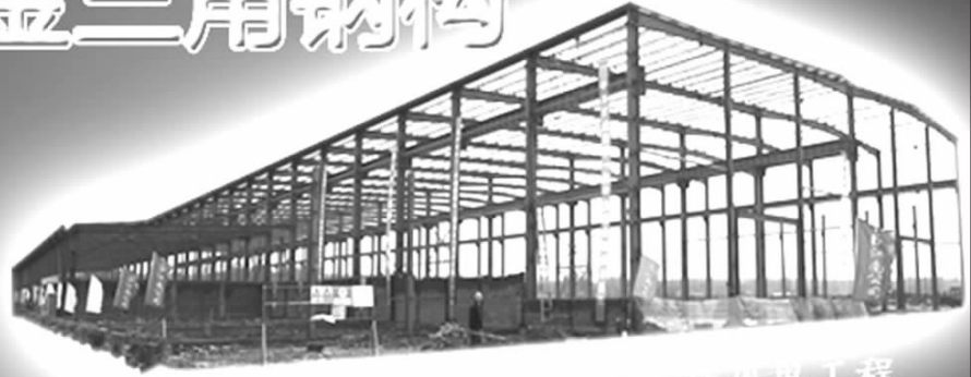
兴德风电工程
