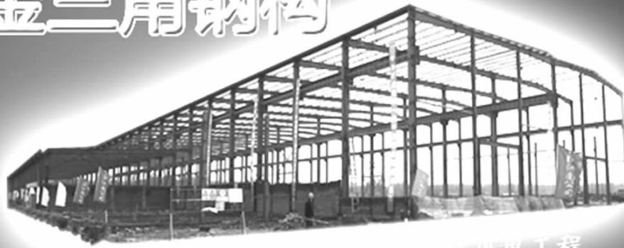
兴德风电工程
